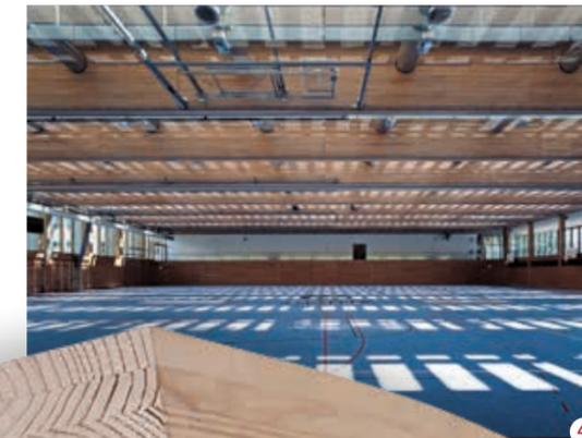
1 Le bois lamellé-collé résiste aux substances chimiques agressives.
