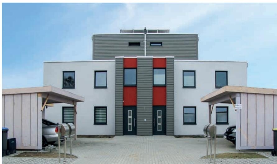
Dans ce bâtiment de 3 étages de 400 m<sup>2</sup> de surface habitable pouvant accueillir jusqu'à quatre familles, les murs extérieurs et intérieurs mais aussi le plafond et la toiture sont en éléments **MMHBE**.
